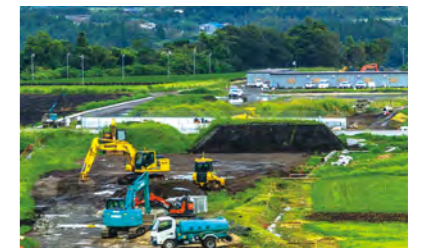
平成30年4月~ 東九州道(志布志~大崎)春日堀地区 外改良工事
