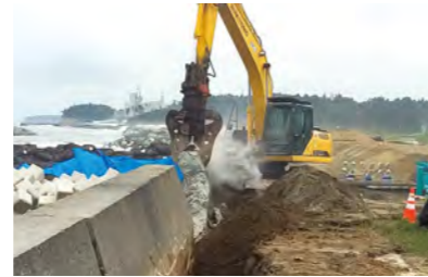
平成 29 年度 公共災害復旧（再復）工事（海岸）
