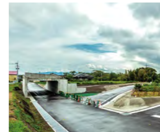
平成30年8月完成 東九州道(志布志~大崎)勢園地区 函渠工工事
