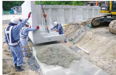
平成 29 年度 片岸・鶏住居地区整備工事
