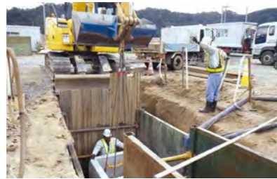
平成 29 年度 片岸・鶏住居地区上下水道工事
