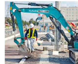
平成30年6月~ 平成30年度浜平地区 簡易パーキング整備工事
