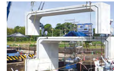
平成30年8月完成 東九州道(志布志~大崎)勢園地区 函渠工工事
