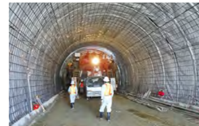
平成30年3月完成 道路整備(交付金)工事(伊座敷トンネル)
