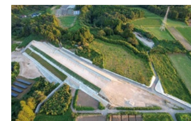
令和5年9月完成 日南・志布志道路立山地区改良工事
