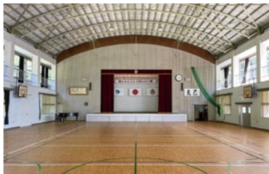
令和 5 年 9 月完成 令和 5 年度田代小学校屋内運動場改修工事
