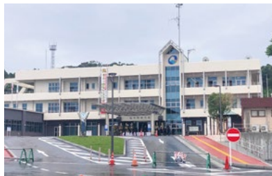
令和 4 年 10 月完成 南大隅町本庁舎外構（電気設備）工事
