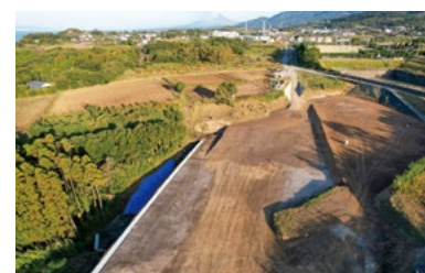
令和5年12月完成 鹿児島220号古里地区 (第8工区)改良工事
