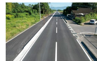
令和5年10月完成 県単道路整備(改良)工事 (有里 R5-3 工区)
