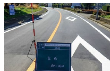
令和6年3月完成 道路補修(交付金)(舗装)工事 (田代麓外 R5-1 工区)
