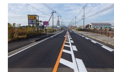
令和2年10月～令和3年12月 令和2年度古江地区構造物補修外工事
