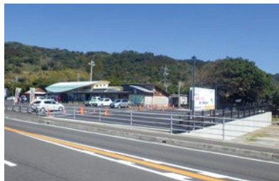
令和 5 年 3 月完成 令和 4 年度にしきの里改修工事
